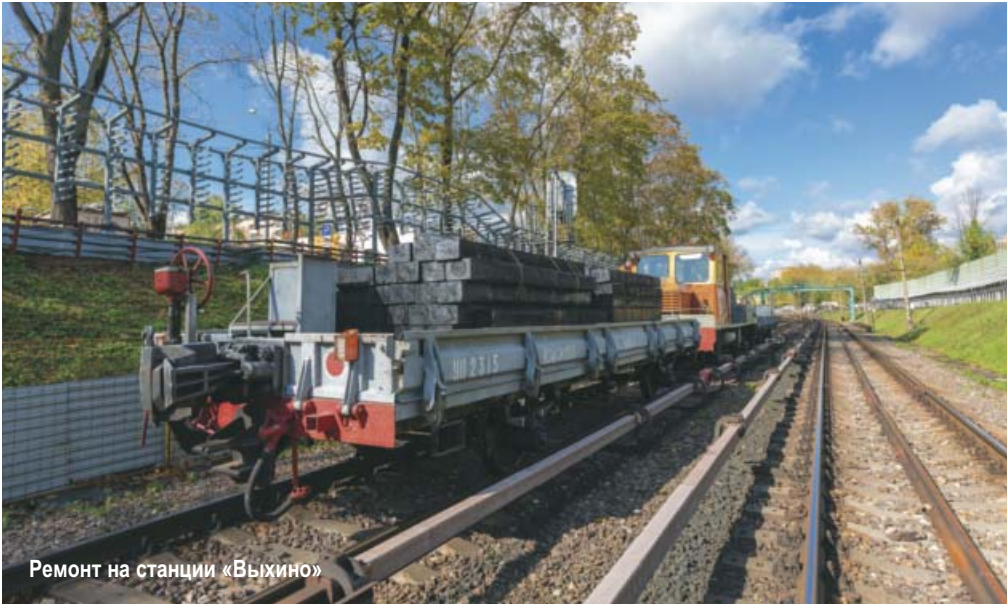
Ремонт на станции «Выхино»
